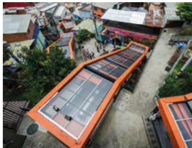
Die 384 Meter lange Rolltreppe ist 28 Stockwerke hoch und in sechs Teilstücke gegliedert. Der Bau kostete umgerechnet über fünf Millionen Euro.
